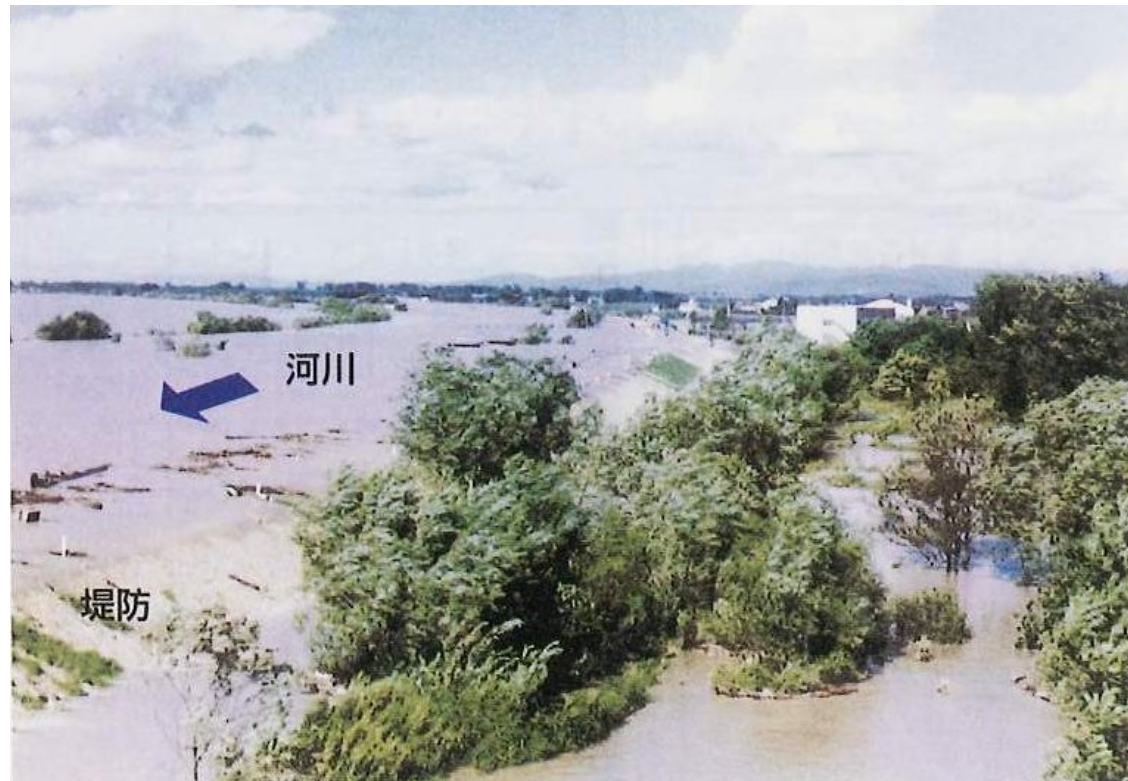
出典：堤防に沿った樹林帯の手引き
