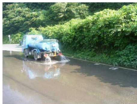
写真 3.2-1 散水の実施状況
