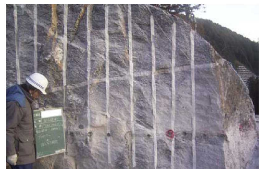
写真 3.2-9 騒音の低減(静的破碎工法)
