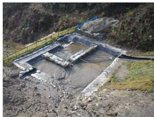
写真 3.2-4 沈砂池の設置状況
