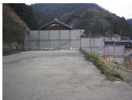
写真 3.2-2 防音壁の設置状況
