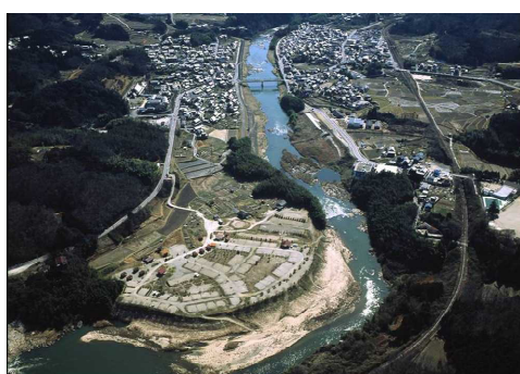
木津川上流（大臣管理区間）51～52k 付近
