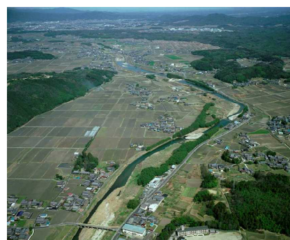
木津川（三重県管理区間）67～69k 付近
