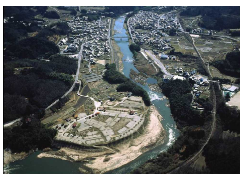
木津川上流（大臣管理区間）51～52k 付近
