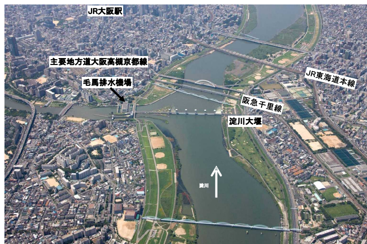
淀川と支川大川の分派点の状況(淀川左岸10.0k付近)
