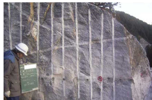
写真 3.2-9 騒音の低減(静的破碎工法)
