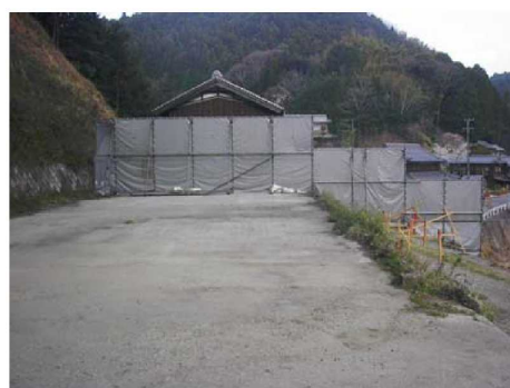
写真 3.2-2 防音壁の設置状況
