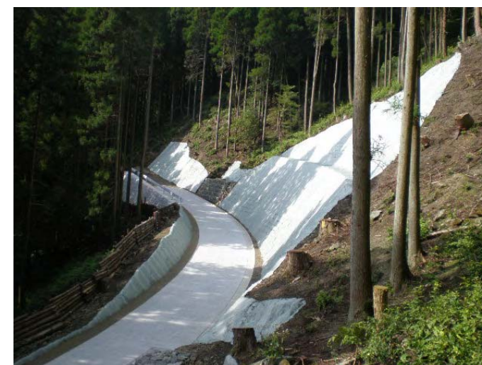
付替林道進入路
