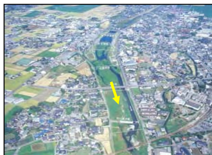
小石原川中流部（県管理区間）
