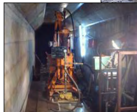
グラウチング状況（他ダム事例）
