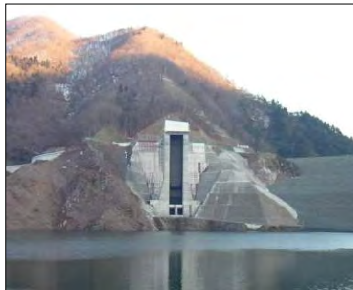
取水設備写真（他ダム事例）
