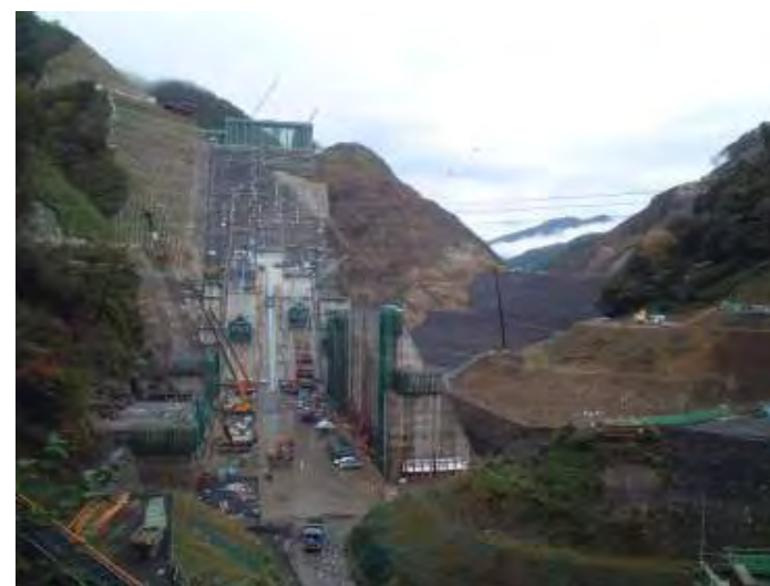
洪水吐き施工状況（他ダム事例）
