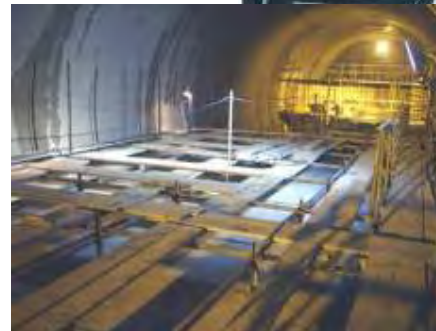
仮排水路トンネル閉塞状況写真（他ダム事例）
