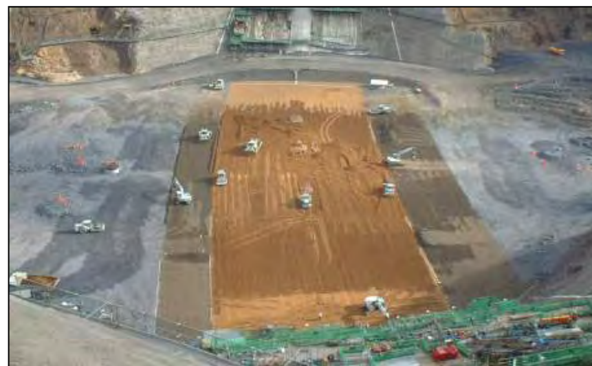
堤体工状況写真（他ダム事例）
