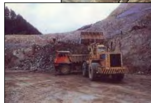
掘削工（他ダム事例）
