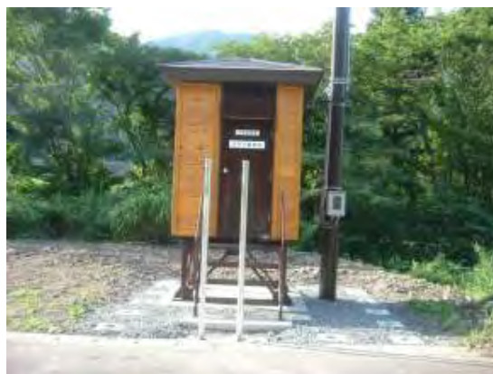
警報局舎写真 (他ダム事例)
