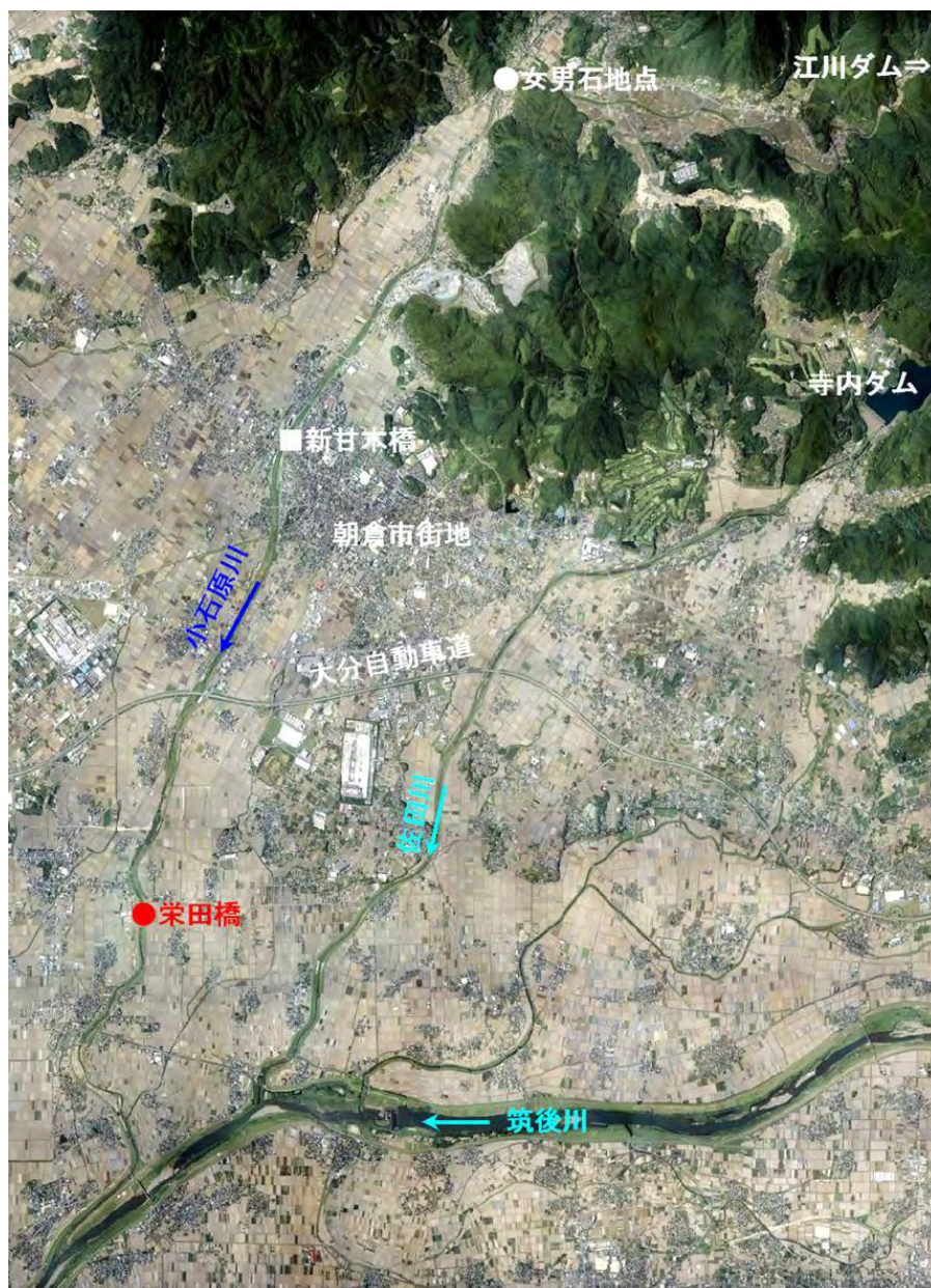
図 2.3-1 小石原川下流部の現状
