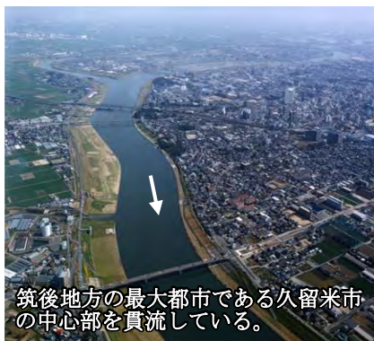
写真 2.1-11 久留米市周辺（豆津橋付近）
