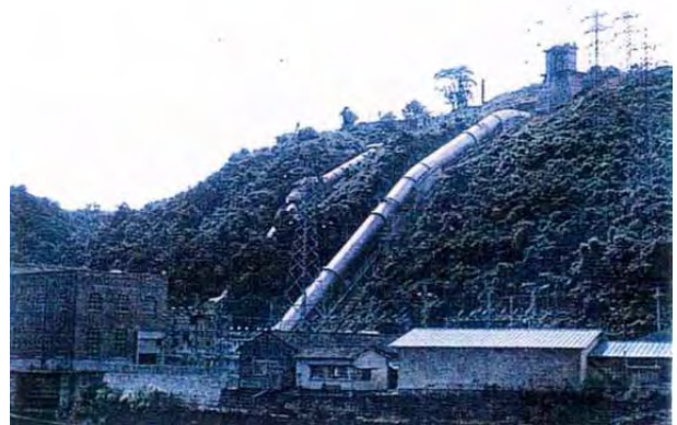
写真 2.2-5 女子畑発電所（日田市天瀬町）
