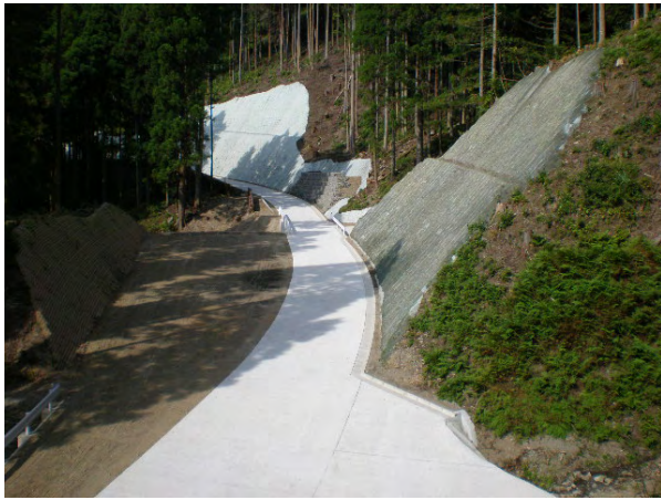
写真 3.3-1 付替林道 水浦 1号進入路
