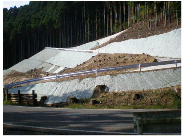
写真 3.3-2 付替林道 水浦 2号進入路
