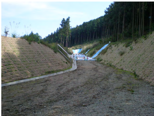
写真 3.3-3 付替国道 進入路
