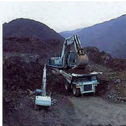
写真 2.3-2 原石の採取の工事の例
