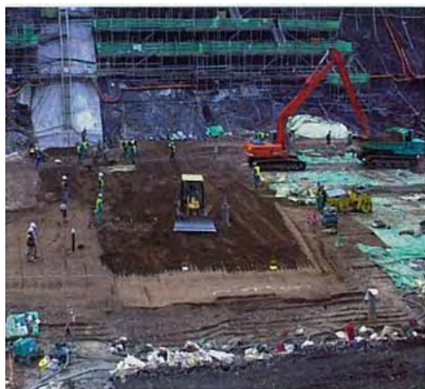
写真 2.3-1 ダムの堤体の工事の例
