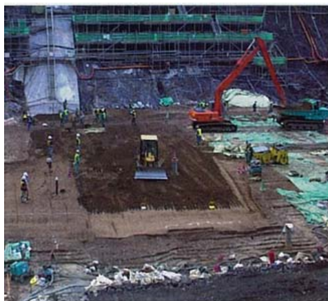
写真 2.3-1 ダムの堤体の工事の例
