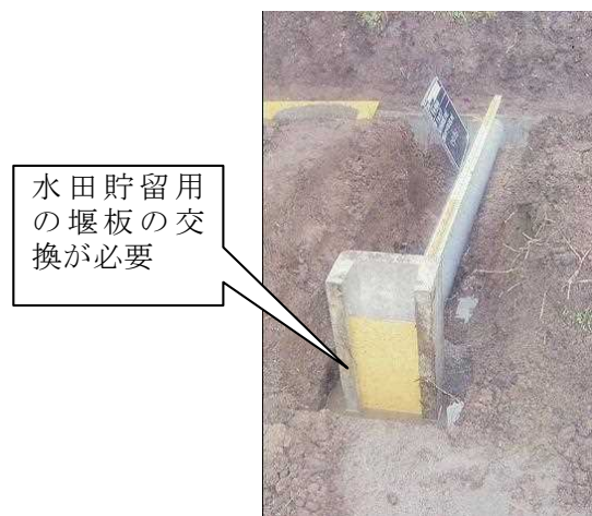
写真 4.8 水田排水ますの例
