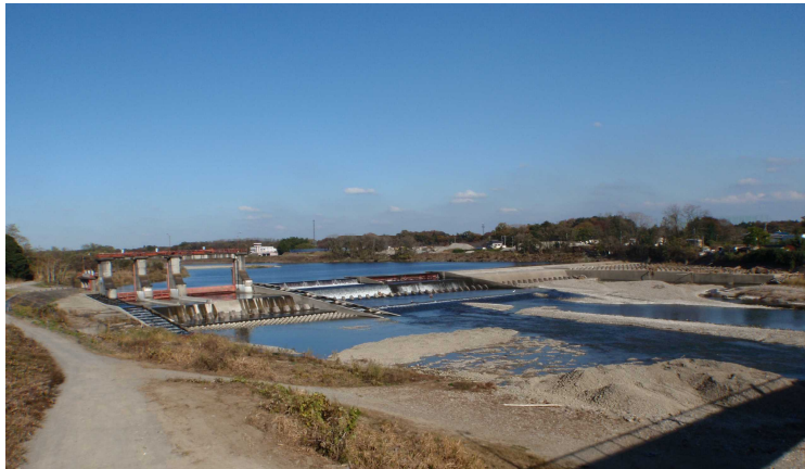
写真 2.2-7 大光寺堰（美田東部頭首工）
