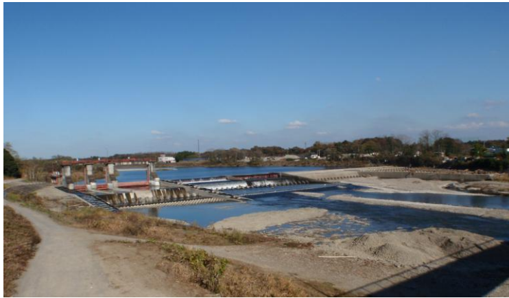
写真 2.2-7 大光寺堰（美田東部頭首工）
