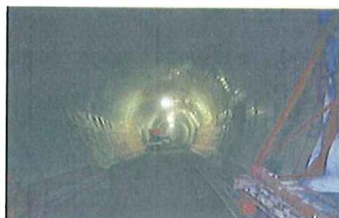
d) 仮排水トンネル
