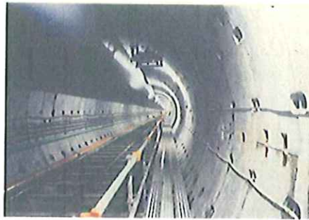
a) 利根導水路
