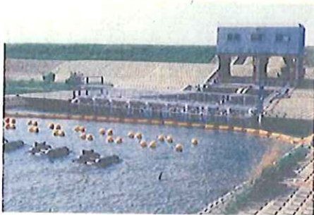
c) 利根樋管
