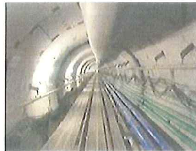
d) 石岡トンネル (建設中)
