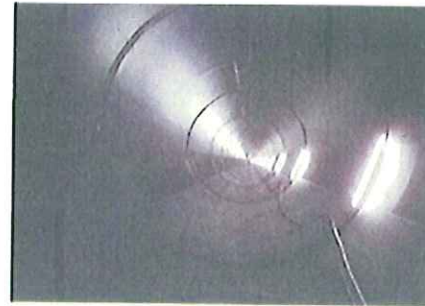
d) 第6工区トンネル
