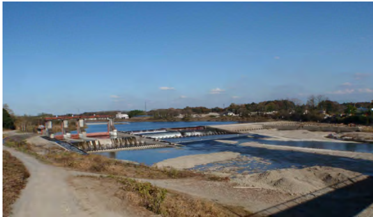
写真 2.2-7 大光寺堰（美田東部頭首工）
