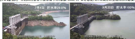
早明浦ダム左岸展望台からの写真(左:貯水率低下時、右:満水時)
