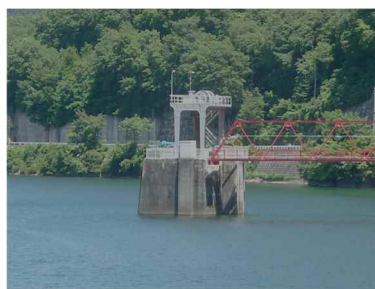
取水塔からの放流による発電 (関西電力)
