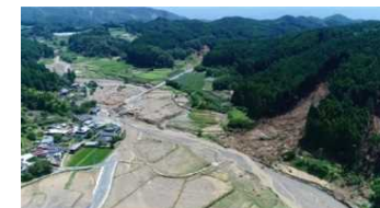
被災状況調査(福岡県朝倉市)
