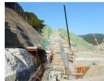
ダム洪水吐き工事 (小石原川ダム)
