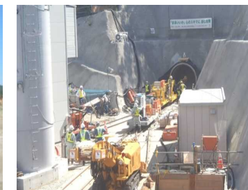
併設水路工事 (豊川用水東部幹線)
