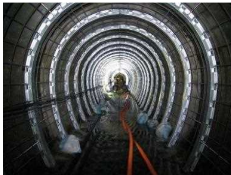
群馬用水緊急改築事業(有馬トンネル)(左:内面補強工事、右:完成)
