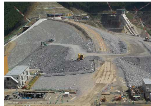
小石原川ダム建設事業(ダム左岸側より撮影)
