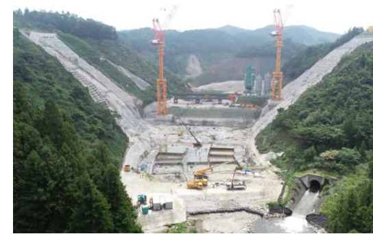
川上ダム建設事業(ダム下流より撮影)
