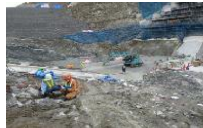
ダム本体工事の施工管理支援 (安威川ダム)
