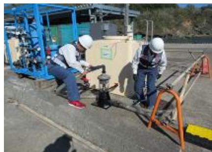
可搬式浄水装置による給水支援状況
