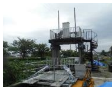
大学と連携した実証実験 (ケーブル制震工法)
