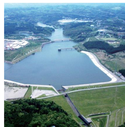
房総導水路(長柄ダム)
