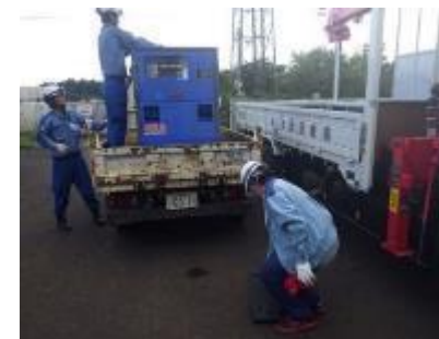
発電発電機による電源供給支援状況
