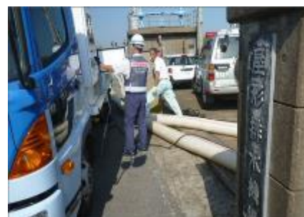
ポンプ車による排水支援状況
