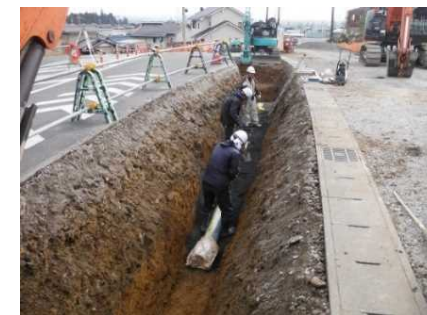
木曾川右岸緊急改築事業 管路敷設替え状況
