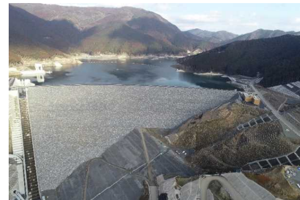
小石原川ダム
