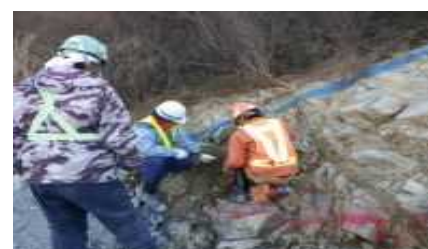
ダム本体工事の施工管理支援(安威川ダム)
