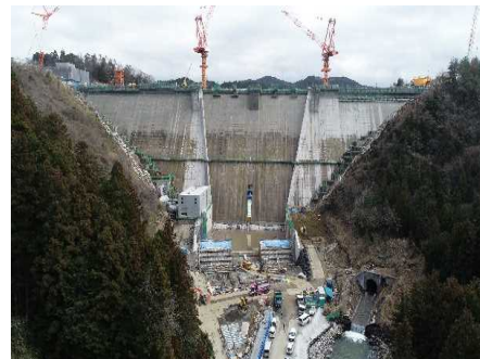
川上ダム コンクリート打設状況
