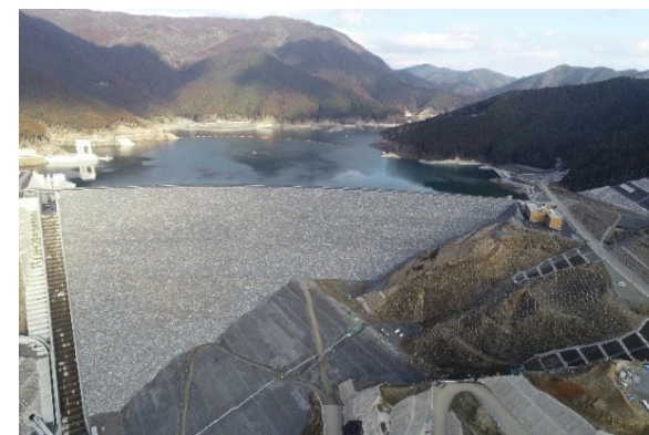
小石原川ダム
