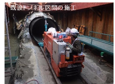
内挿ダクタイル鋳鉄管の運搬
