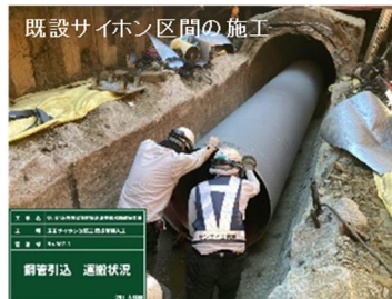
内挿鋼管の運搬
