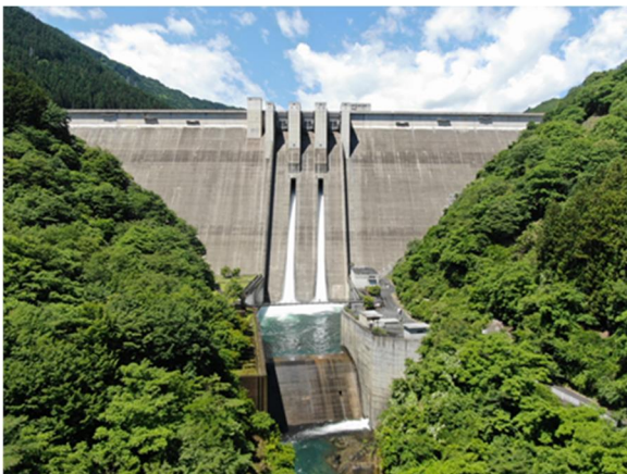
滝沢ダム(洪水吐きゲート遠隔操作による放流)
