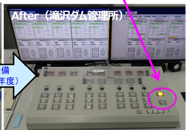
放流設備遠隔操作化のための整備状況(滝沢ダム・荒川ダム総合管理所)
