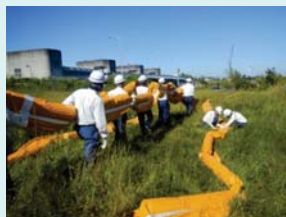
オイルフェンス準備
