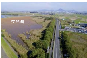
湖岸堤防（湖岸堤・管理用道路）
