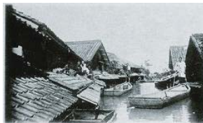
家が浸かる被害！ (明治29年9月)
