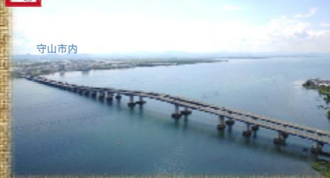
琵琶湖を初めて横断し、湖の東と西を直結させた有料橋です。昭和39年9月に開通しました。琵琶湖でもっとも狭い部分である大津市の堅田と守山市の今浜を結び、この橋を境に琵琶湖は北湖と南湖に分かれます。長さ1350m・最大の高さ26.3mの鋼鉄製です。アーチ型の白い橋は、湖岸のアクセントです。
