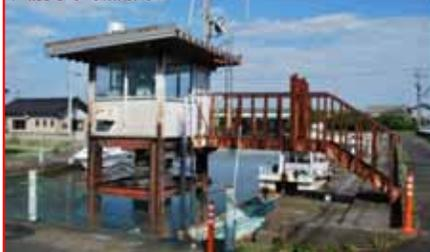
琵琶湖の水位は、現在、片山、彦根、大溝、堅田、三保ヶ崎の5箇所の水位観測所に設置された水位計の測定値の平均値としています。
