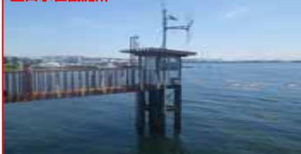
かつては、塩津、片山、彦根、大溝、沖之島、堅田、三保ヶ崎、鳥居川の水位観測所に設置された水位計の測定値のうち、鳥居川の水位を琵琶湖の水位としていましたが、琵琶湖全体の水面は水平ではなく、波や風による吹き寄せ、セイシュと呼ばれる湖面の振動などにより一定ではないため、現在は5箇所の平均値としています。
