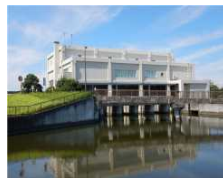
大同川排水機場
