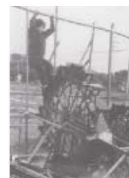
水田に水を引いたり、水田に溜まった水を琵琶湖に汲み出すために使っていた足踏水車 <高島町民俗資料館蔵>
