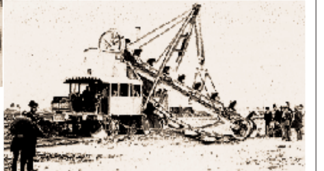
淀川で使われた当時の掘削機
