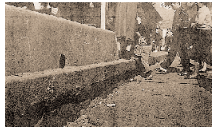
地盤沈下によって陥没した道路<大阪水道局蔵>
