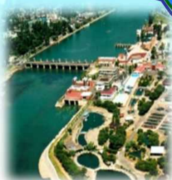
瀬田川洗堰およびバイパス水路
