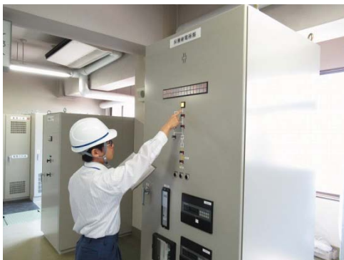
電気通信施設点検実施状況
