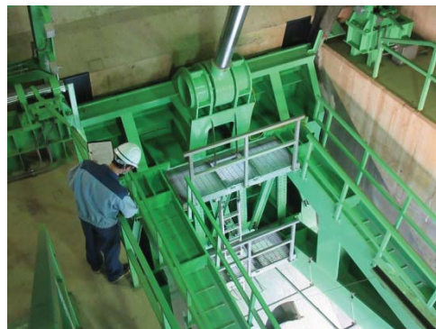
機械設備点検実施状況
