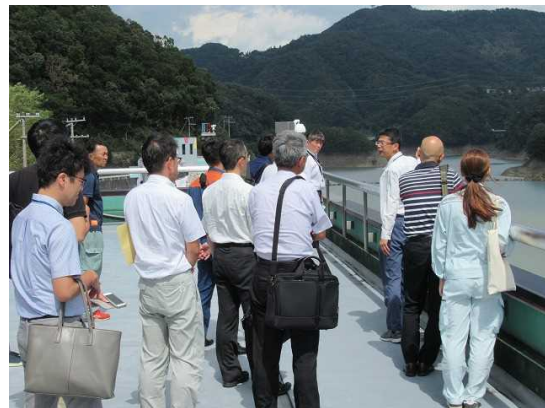
管理所屋上からダムと貯水池の説明
