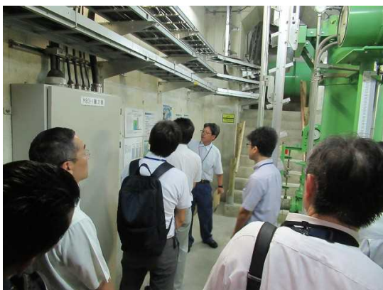
堤体内設備の説明
