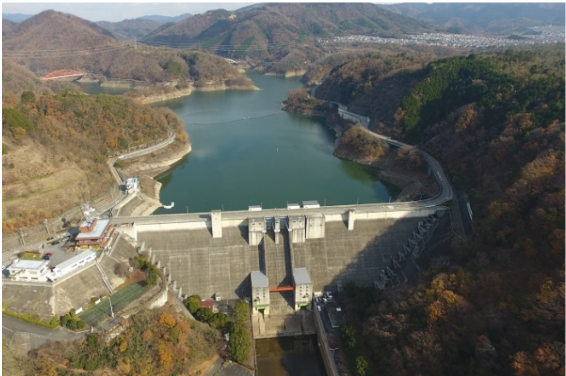
貯水池の状況（H30.12.19撮影）貯水位 EL.136.44m（平年値：EL.135.41m）
