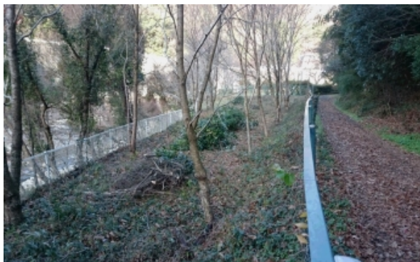
エドヒガン桜周辺雑木伐採（ダム下流左岸広場）
