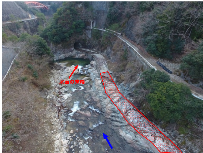
貯水池管理用道路復旧工事予定箇所の状況 (H30. 12. 19 撮影)
