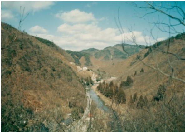
工事着手前のダムサイト
