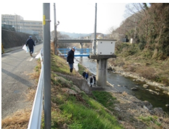
畦野水位観測所と周辺の様子
