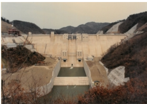
竣工直前の状況（S57.3）
