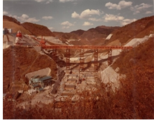
ダム本体打設時の状況（S54.3）
