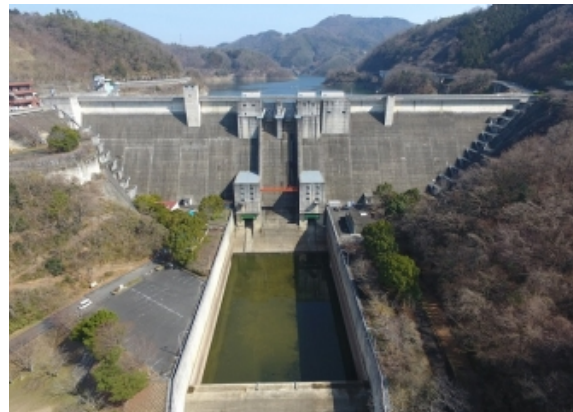
湛水後37年を経過した現在の状況
