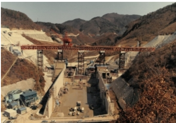
ダム本体打設時の状況（S55.3）
