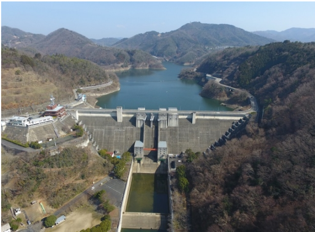
貯水池の状況 (H31. 3. 5 撮影) 貯水位 EL. 138. 99m (平年値 EL. 138. 72m)
