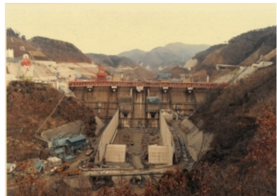
ダム本体打設時の状況（S56.3）
