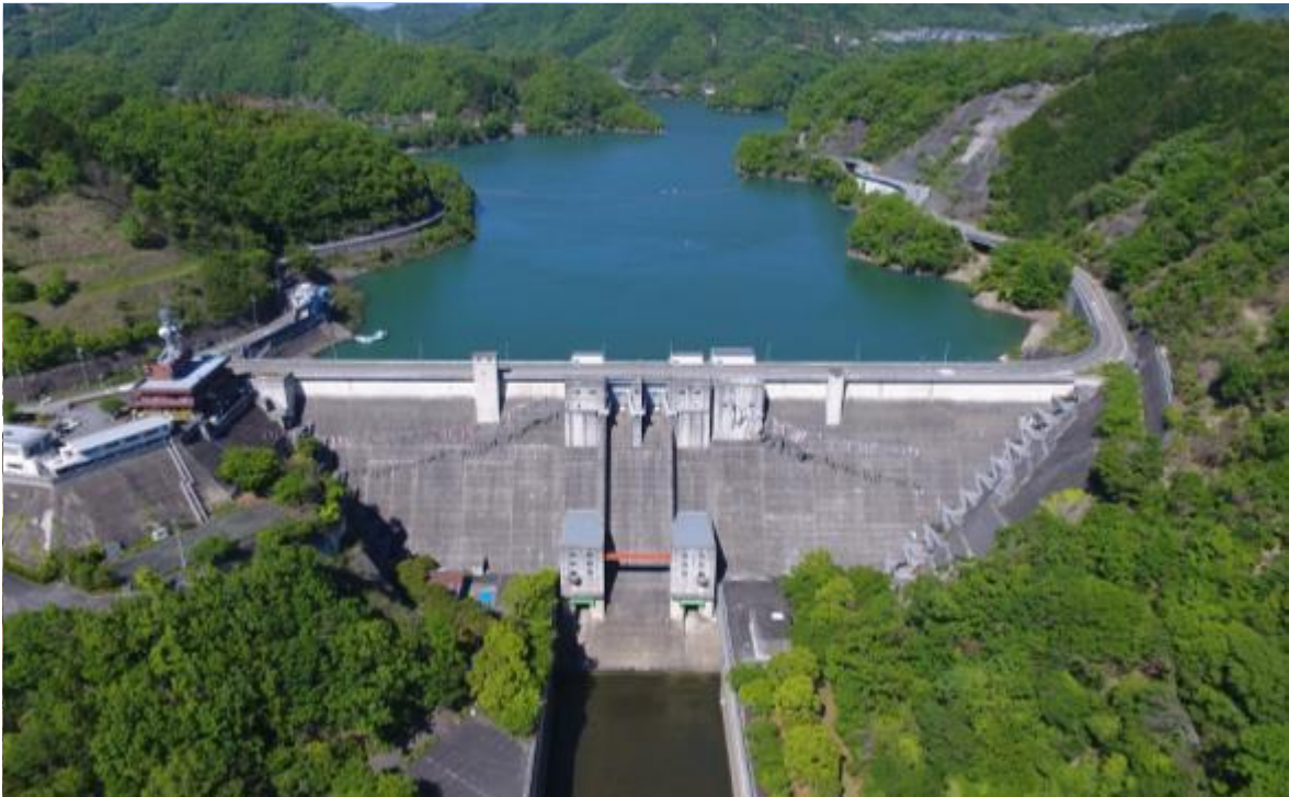
貯水池の状況 (R1. 5. 7 撮影) 貯水位 EL. 144. 19m (平年値 EL. 142. 29m)
