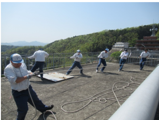
いざ、引っ張り上げます。
