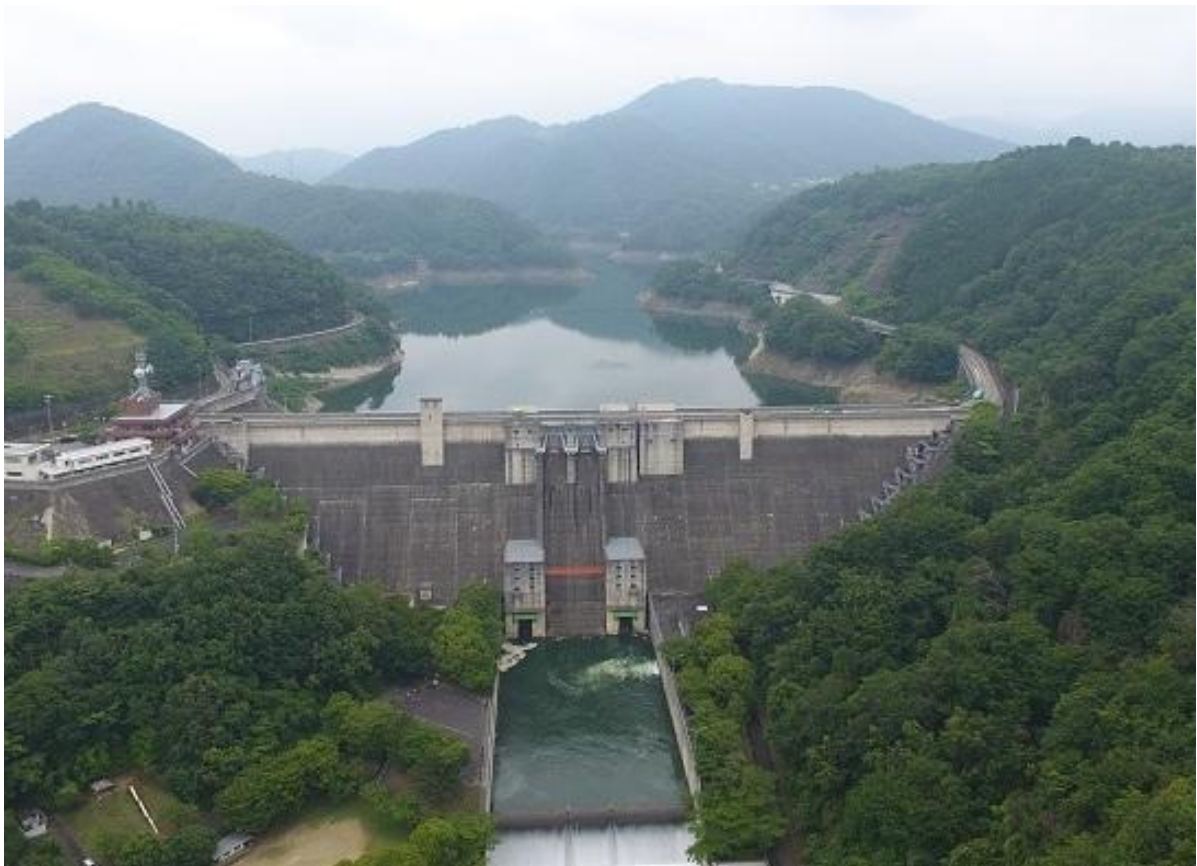
貯水池の状況（R1.7.3撮影） 貯水位 EL. 135.16m（平年値 EL. 134.75m）
