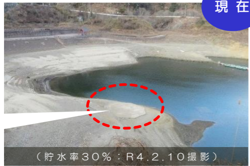
建設当時の面影が見られる八角形のプラント基礎。
