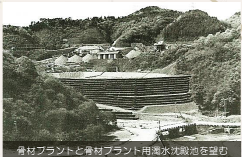
骨材プラントと骨材プラント用濁水沈殿池を望む
