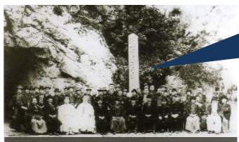
龍化隧道完成写真 (T5撮影) 出典:「写真集 湖底に沈んだ千軒道・国崎道」 著者・塩田豪一
