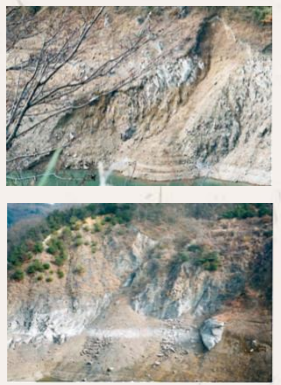
貯水池法面崩落の様子
