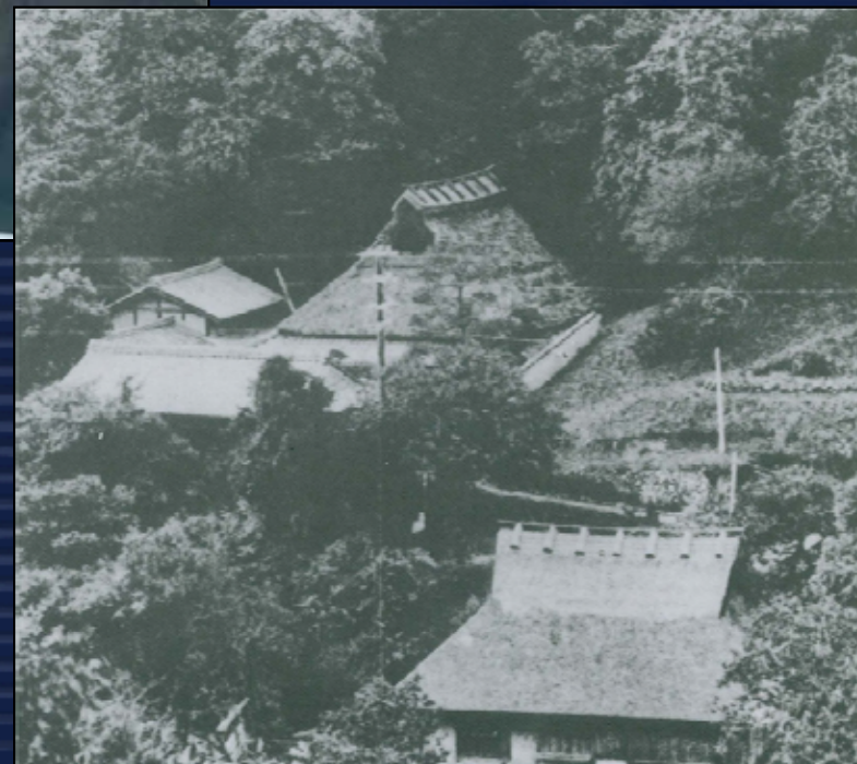
水没する民家
