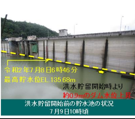
ダム貯留状況写真
