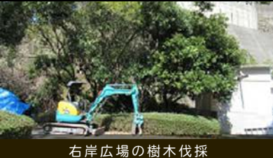
右岸広場の樹木伐採
