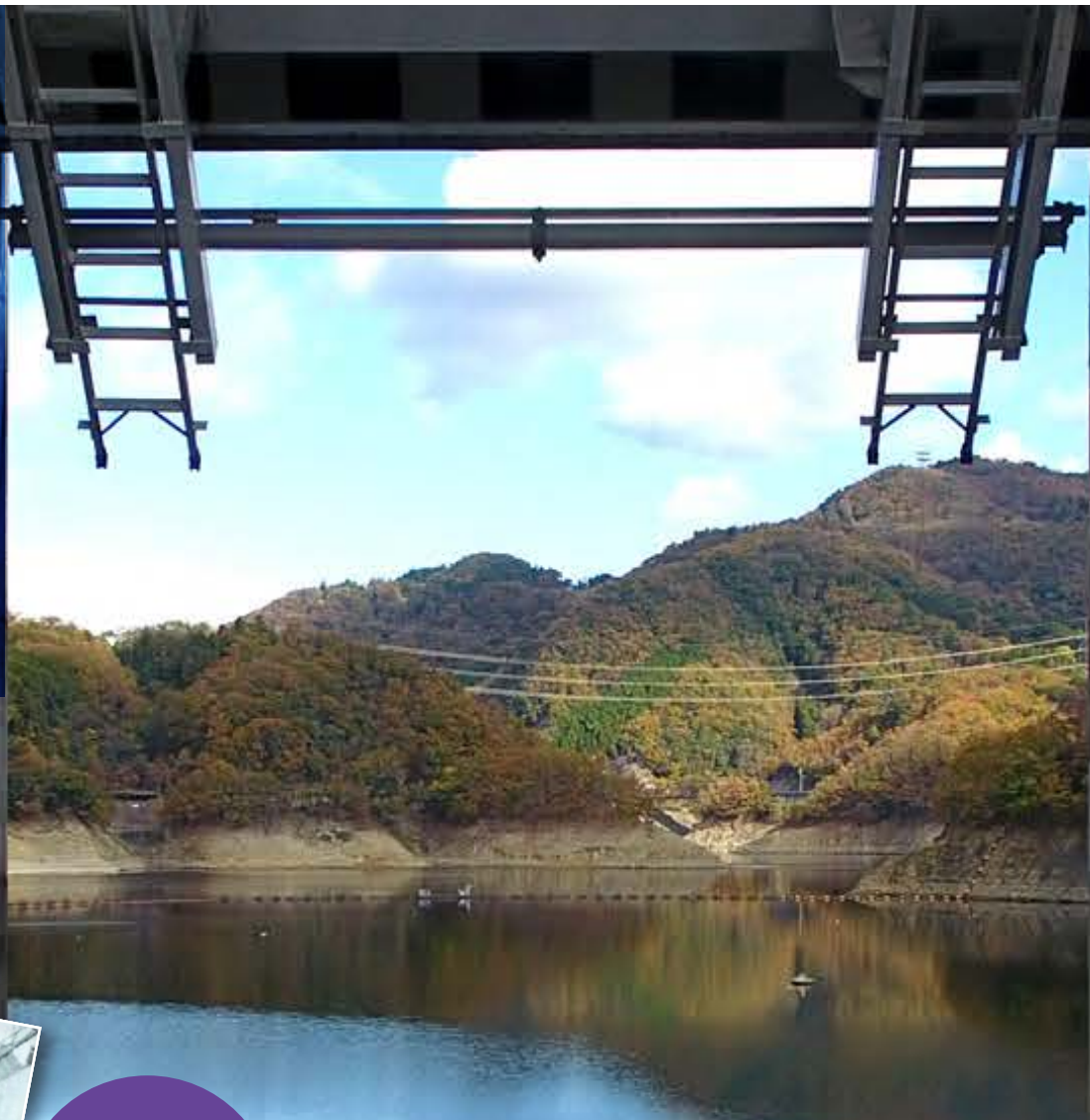
クレストゲートから見た貯水池（ドローン撮影）
