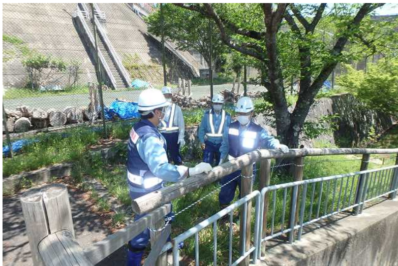
遊歩道手すりの安全確認
