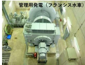
ダムから放流する水の一部を利用して、最大1900kWの水力発電を行っています。発電した電気は管理所の照明や放流設備の動力などに使うとともに、余剰分は電力会社に売電し、管理費用の軽減を図っています。
