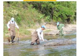
一時的に放流量を増やすとともに、貯水池上流等に堆積している土砂をダム下流に運搬・投入することで、玉石等に付着している藻類やゴミを洗い流し、河床をきれいになります。
