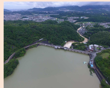
最大限洪水を貯め込んだ一庫ダム（7月7日）（貯水位148.27m）
