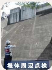
堤体周辺点検
