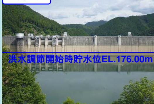
洪水調節開始時貯水位EL.176.00m
