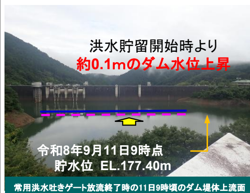
ダム貯留状況写真
