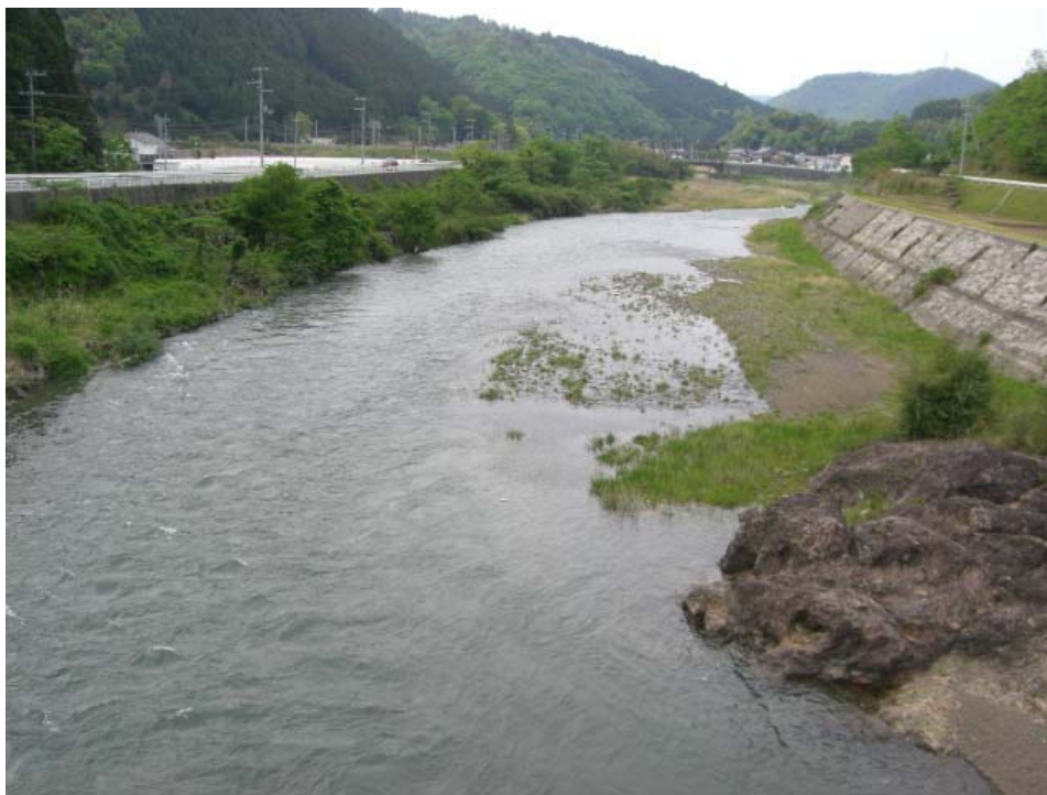
最大放流時の状況（放流量毎秒 27 立方メートル） 撮影場所：田原川合流点より約 200m 下流付近
